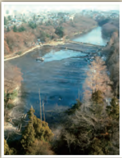
▲ 1985年～1988年 ヘドロ除去の工事で水を 全部抜いたところ。
