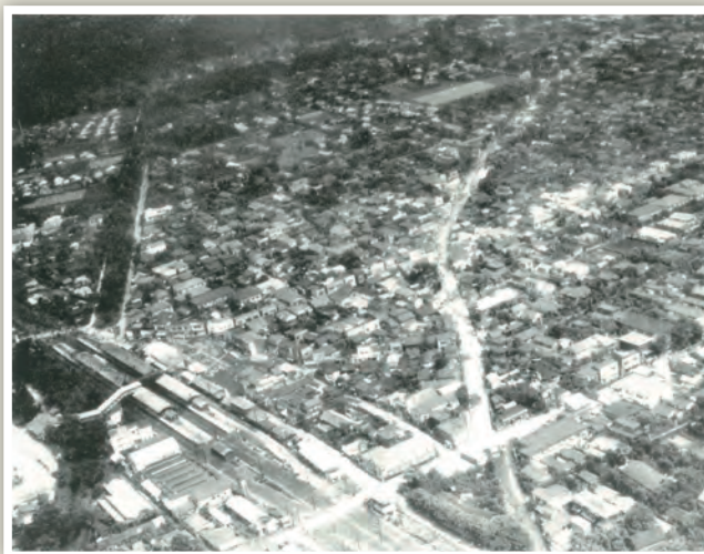
▲ 昭和32(1957)年頃の三鷹駅南口[北西側からの航空写真] 左下が三鷹駅、中央右を縦に走る白い道がさくら通り (三鷹市教育委員会発行『写真集 みたかの今昔』より)
